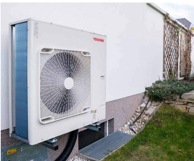
Obiteljska kuća u Bad Vöslau, Technology Systems
